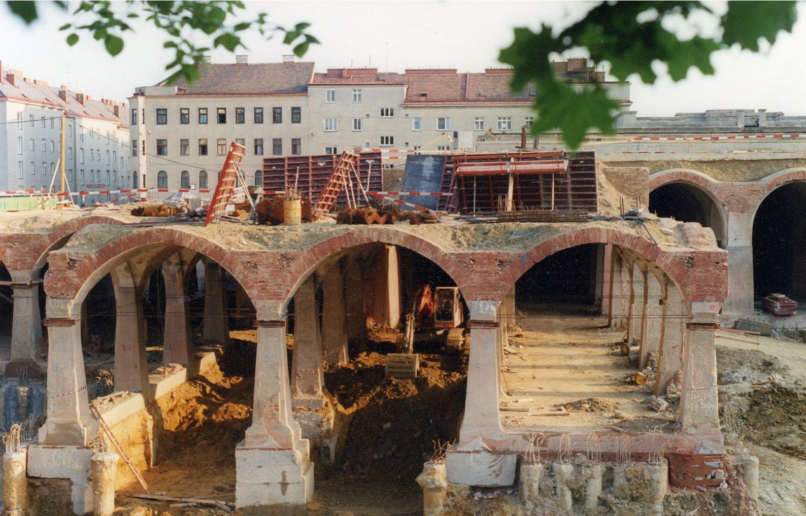
Bild: Umbau des Behälter Schmelz (1993); Bild: Robert Schediwy auf wikipedia
